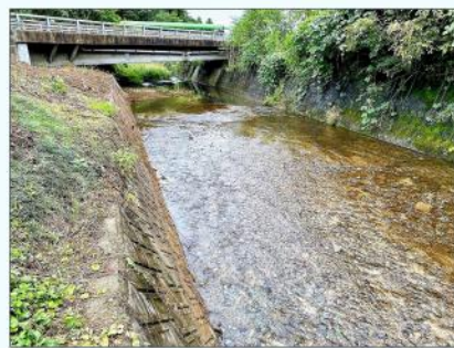
②志賀沢側の除草・浚渫 (岩沼市志賀・小川地区)
