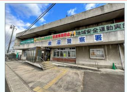
昭和40年に建設された南庁舎
